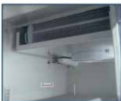
evaporador en el techo top mounted evaporator
