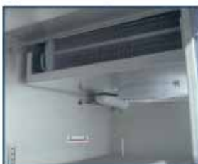
evaporador en el techo top mounted evaporator
