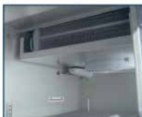
evaporador en el techo top mounted evaporator
