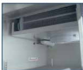
evaporador en el techo top mounted evaporator
