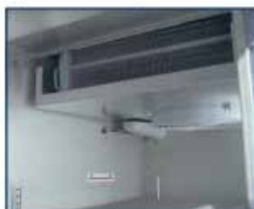
evaporador en el techo top mounted evaporator
