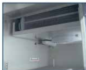
evaporador en el techo top mounted evaporator
