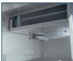
evaporador en el techo top mounted evaporator
