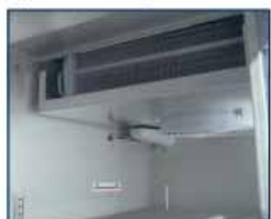
evaporador en el techo top mounted evaporator
